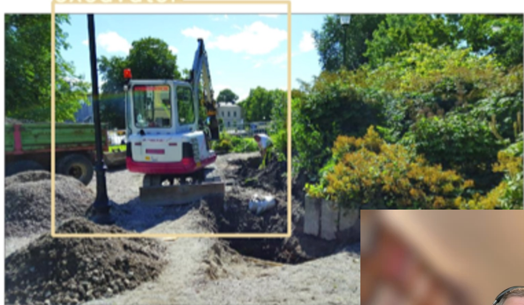
Figur 10. Schakt 3. I bakgrunden isbaktas for ny elkabel. Foto från nordis
